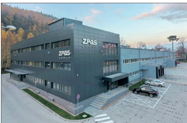
Нова Руда – Дрогослав (Nowa Ruda – Drogoślav), ул. Пилсудского Производственный цех по сборке электрического оборудования
